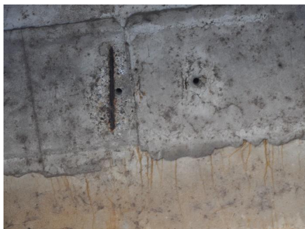
Distacco del calcestruzzo ed esposizione delle barre d'armatura
