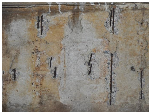
Distacco del calcestruzzo ed esposizione delle barre d'armatura
