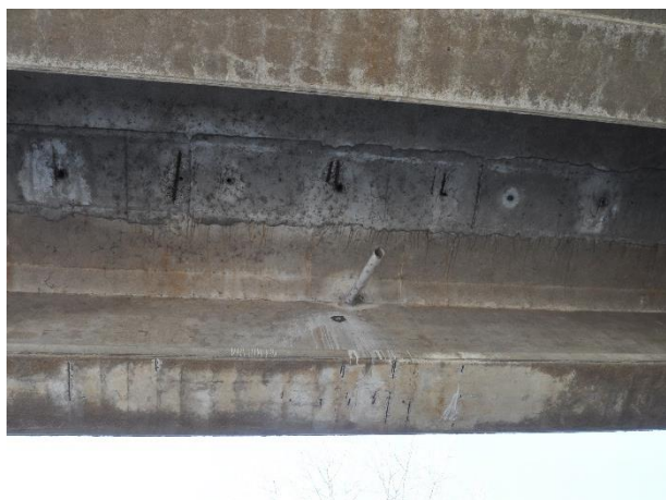
Distacco del calcestruzzo ed esposizione delle barre d'armatura
