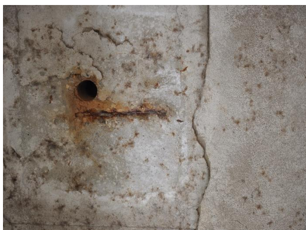
Distacco del calcestruzzo ed esposizione delle barre d'armatura
